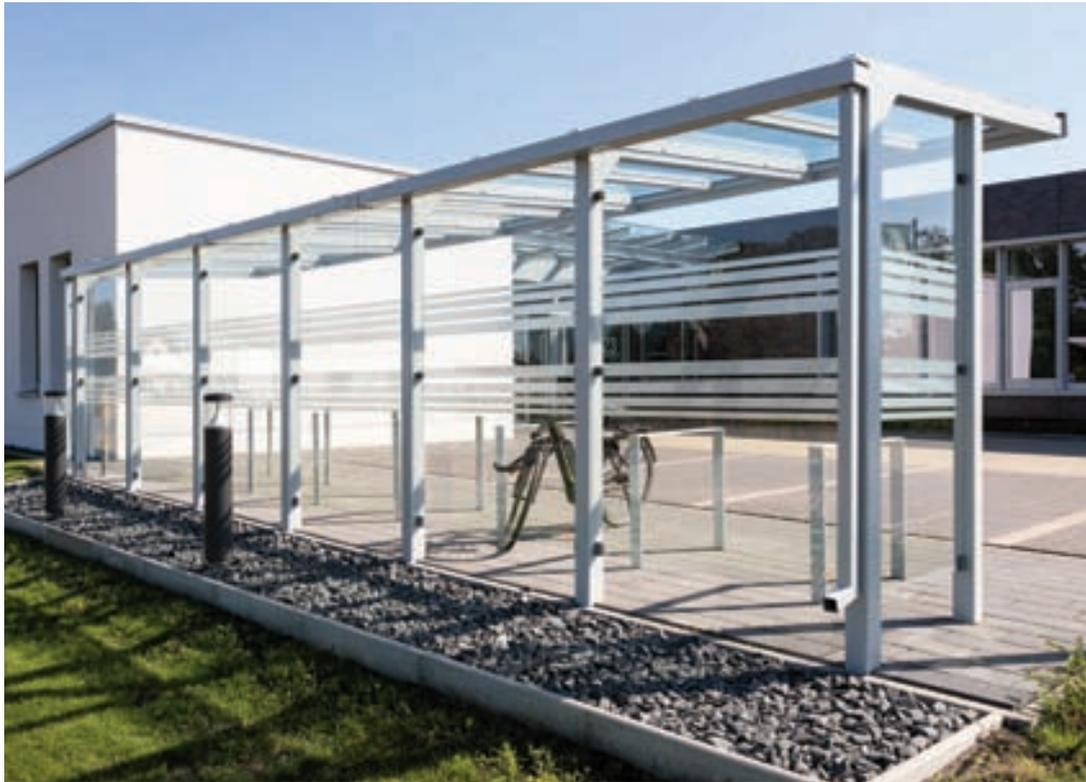
Elegante, frei auskragende Konstruktion ohne vordere Stützen oder Unterzug. Seitliche Stützen werden nur im Falle der Verglasung benötigt
